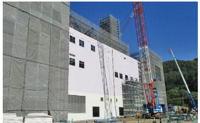
施設外壁（西側）
