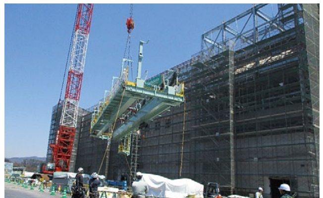
プラント機器の搬入
